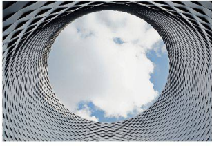
Coverfoto von Fotograf Iwan Baan : Der Lichthof der neuen Messe Basel von Herzog & de Meuron ist das Markenzeichen des Gebäudes.
