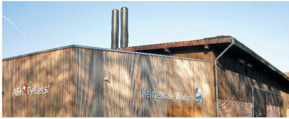
Die Heizzentrale Wylihof in Luterbach verwendet AEK-Pellets.
