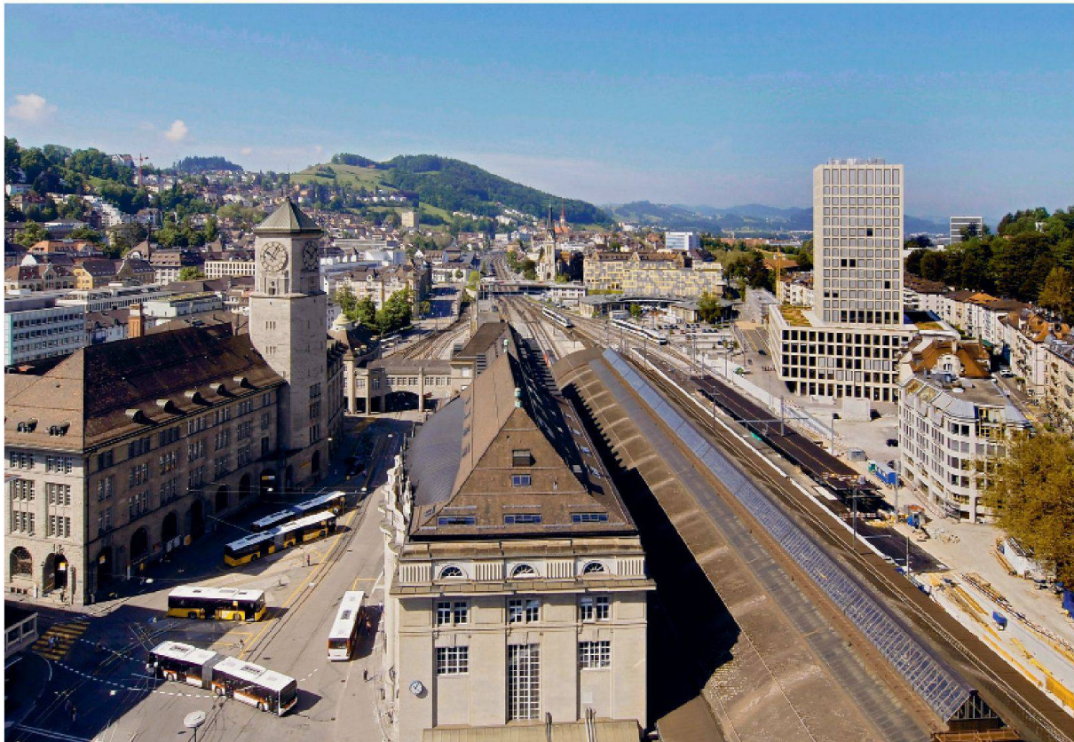
Der Blick vom St. Galler Rathaus zeigt die beiden städtebaulichen Referenzen: ein Turm unter Türmen – der Sockel hält die Höhe der Nachbarbauten.
