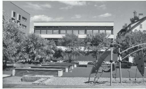
Vorher: Schulhaus Neustadt II in Zug, Baujahr 1966–68. Architektur: Heinrich Gysin und Walter Flüeler, Zug.
