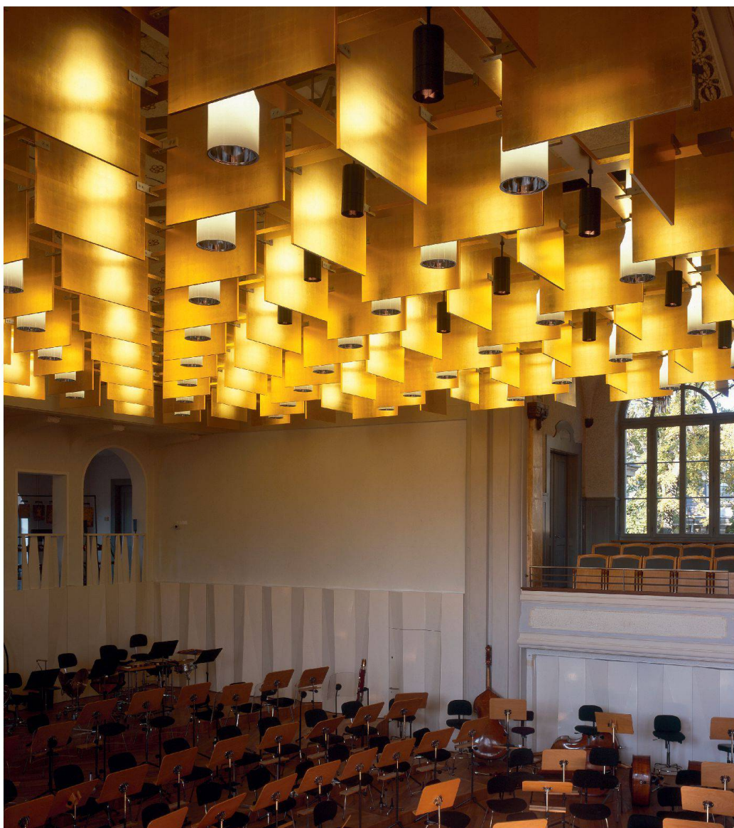
Bühnenbereich der Tonhalle St. Gallen mit dem unter der Decke aufgehängten Schalldiffraktor. Hinter der Bühne sind die schalldiffundierende weisse Holzverkleidung und die Holzbalustrade der Empore mit dem gleichen Zweck erkennbar. Die Bühne ist für ein Orchester mit sehr grosser Besetzung bestuhlt.
