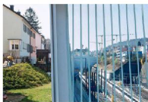
Durch die Lärmschutzwände auf dem Birchsteg Richtung Portalbauwerke geblickt. Coverfoto von Anna-Lena Walther.
