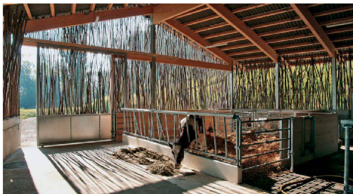
Kuhstall mit Wänden aus Haselruten – 2005 von F.A.B. Architekten in Schönberg bei Pratteln errichtet.
