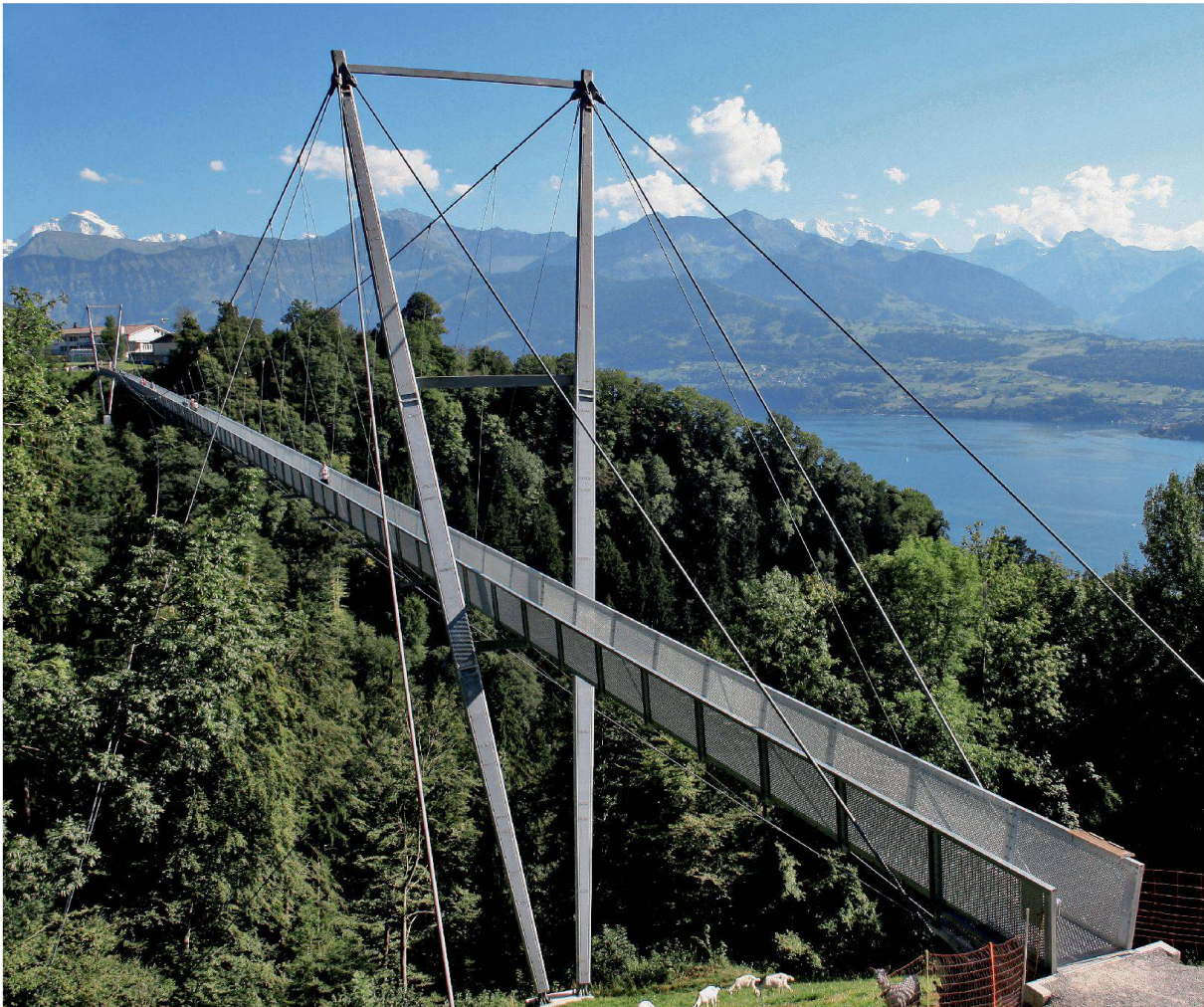
Die Hängebrücke Sigriswil überspannt die Guntenbachschlucht am nördlichen Thunerseeufer in 180 m Höhe. Sie schwebt regelrecht als dünnes Band über dem Talboden (vgl. auch Titelbild dieses Hefts).
