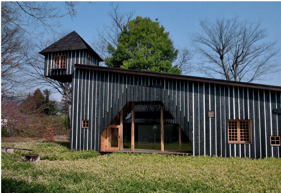
Das Thema einer Höhle war Vorbild für das Yakisugi-Haus. Fujimori verwendete deshalb innen und aussen zwei kontrastierende Hölzer. Aussen wählte er wie bei anderen Bauten Zedernholz. Innen suchte er nach einem stabilen weichen Holz mit unregelmässiger Maserung. Dafür kam nur die japanische Kastanie infrage.
