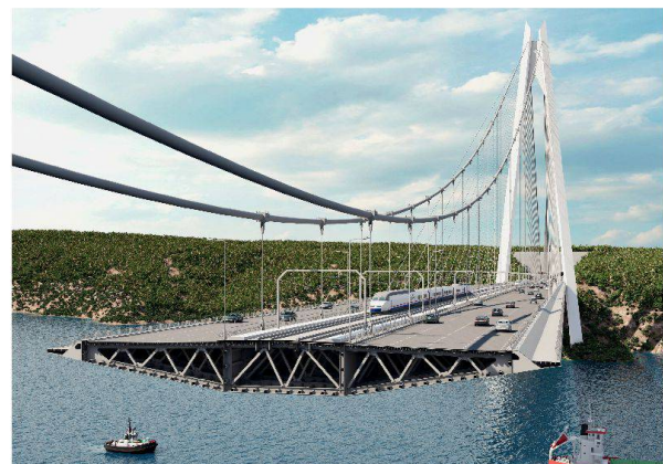
Die 58.5 m breite Fahrbahn trägt zwei Bahnspurten, acht Autobahnstreifen und zwei Fussgängerstreifen.
