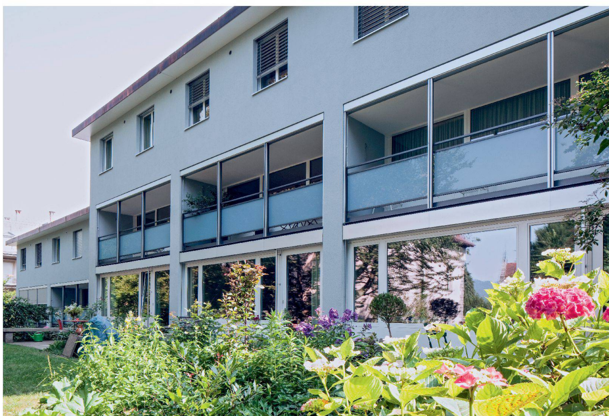
Wohnhaus Riesbach-Quartier: Neue Glasbrüstungen begrenzen die Loggien. Fensterlaibungen im Obergeschoss; Dachvorsprung und Zwischenwände der Loggien zeichnen mit 14 cm Isolationsschicht die Gebäudestruktur stärker nach als zuvor.
