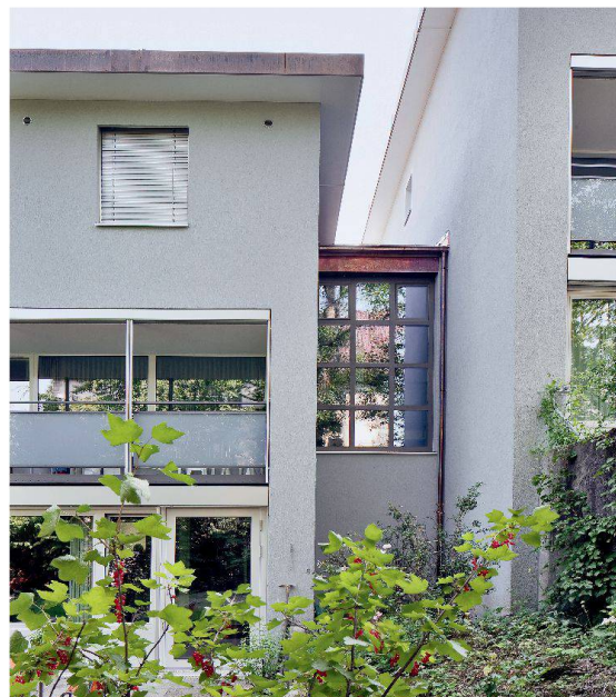
Das Treppenhaus erhielt anstelle der mit einzelnen Betonrahmen unterteilten Einfachverglasungen ein raumhohes Isolierglasfenster.
