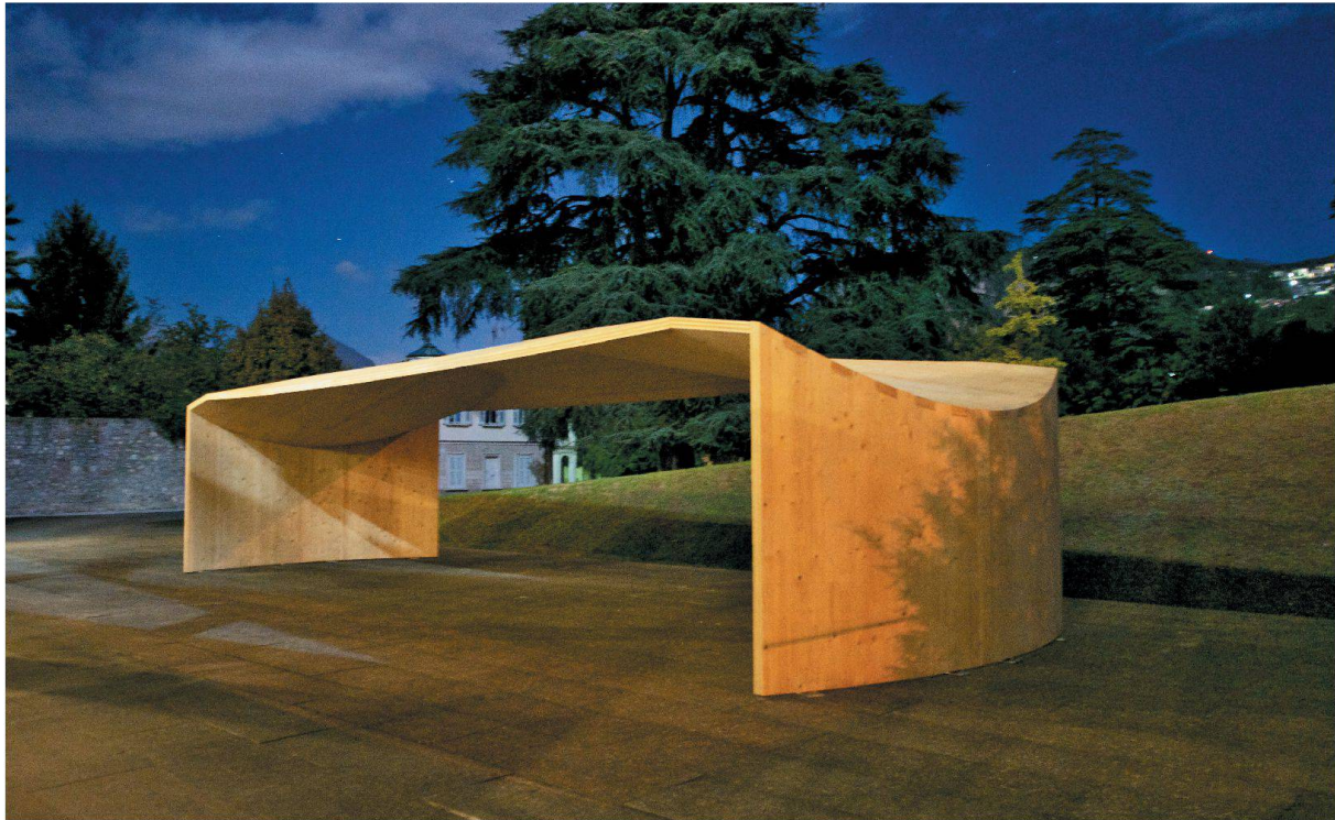
Der Holzpavillon auf dem Gelände der Accademia di Architettura in Mendrisio ist ein Falwerk aus gekrümmten Holzscheiben.
