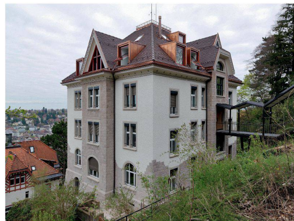
Danach: Kontrastreiche Farben und eine neue Dachlandschaft.
