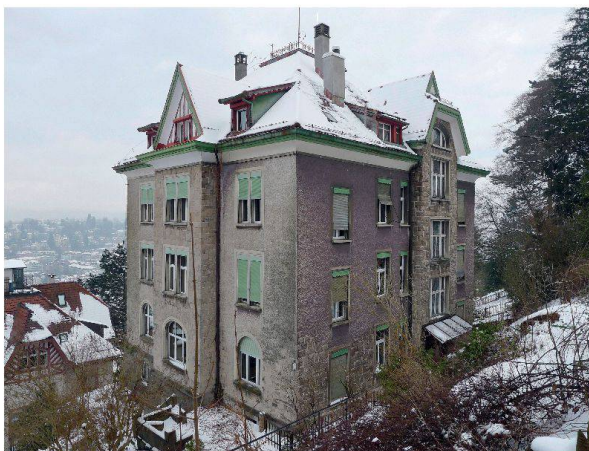
Vor der Sanierung: Trübe Farben verschleiern die Strukturen.
