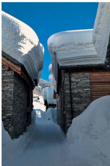
Vor allem Schneelasten führen oft zu erhöhten Lasteinwirkungen auf die Tragwerke: verschneite Häuser im winterlichen Bosco Gurin TI.
