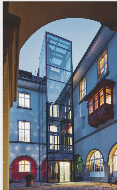
Historisches und Völkerkundemuseum St. Gallen: Der verglaste Liftschacht setzt einen auffälligen Kontrast zum historischen Gebäude.
