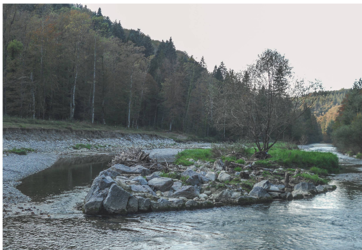
Revitalisierter Abschnitt der Töss im Linsental bei Winterthur. Solche Flussaufweitungen waren nicht überall möglich, denn im Gebiet befinden sich sechs Trinkwassererfassungen der Stadt Winterthur.
