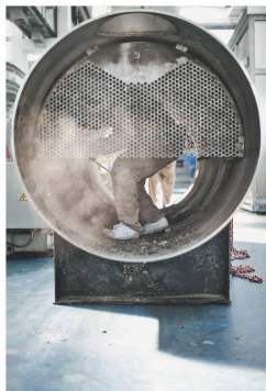
Jahrzehntelanges Arbeiten im Sperrbezirk: Trennarbeiten im Kühler des Kernkraftwerks Lubmin bei Greifswald.
