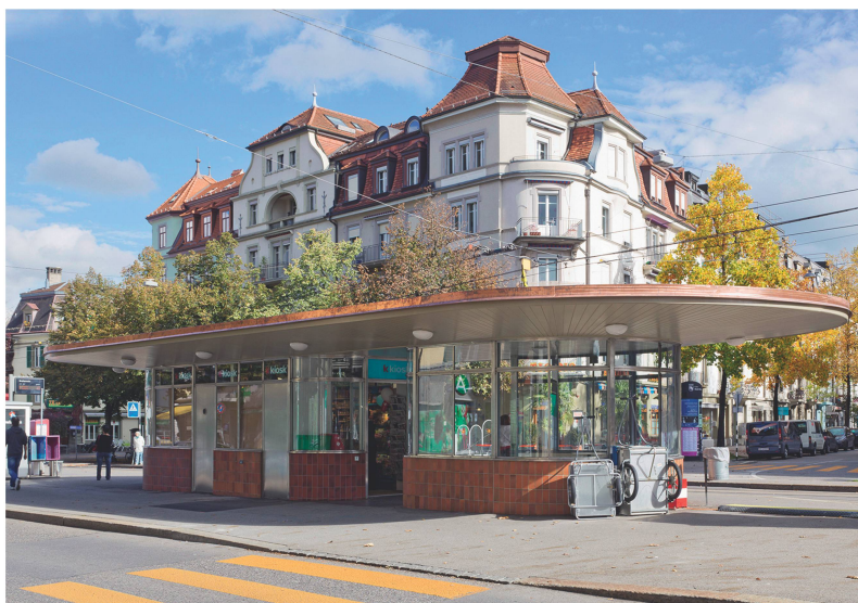
Das denkmalgeschützte Tramwartehäuschen besteht aus einer offenen Warte Halle auf der einen sowie aus einer Toilettenanlage und einem Kiosk auf der anderen Seite. Ein ausladendes Dach fasst die beiden Körper zusammen.
