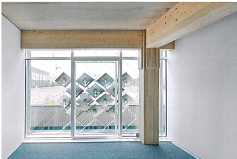
Blick aus einem Büro: adaptive Solarpaneele an der Fassade des House of Natural Resources.
