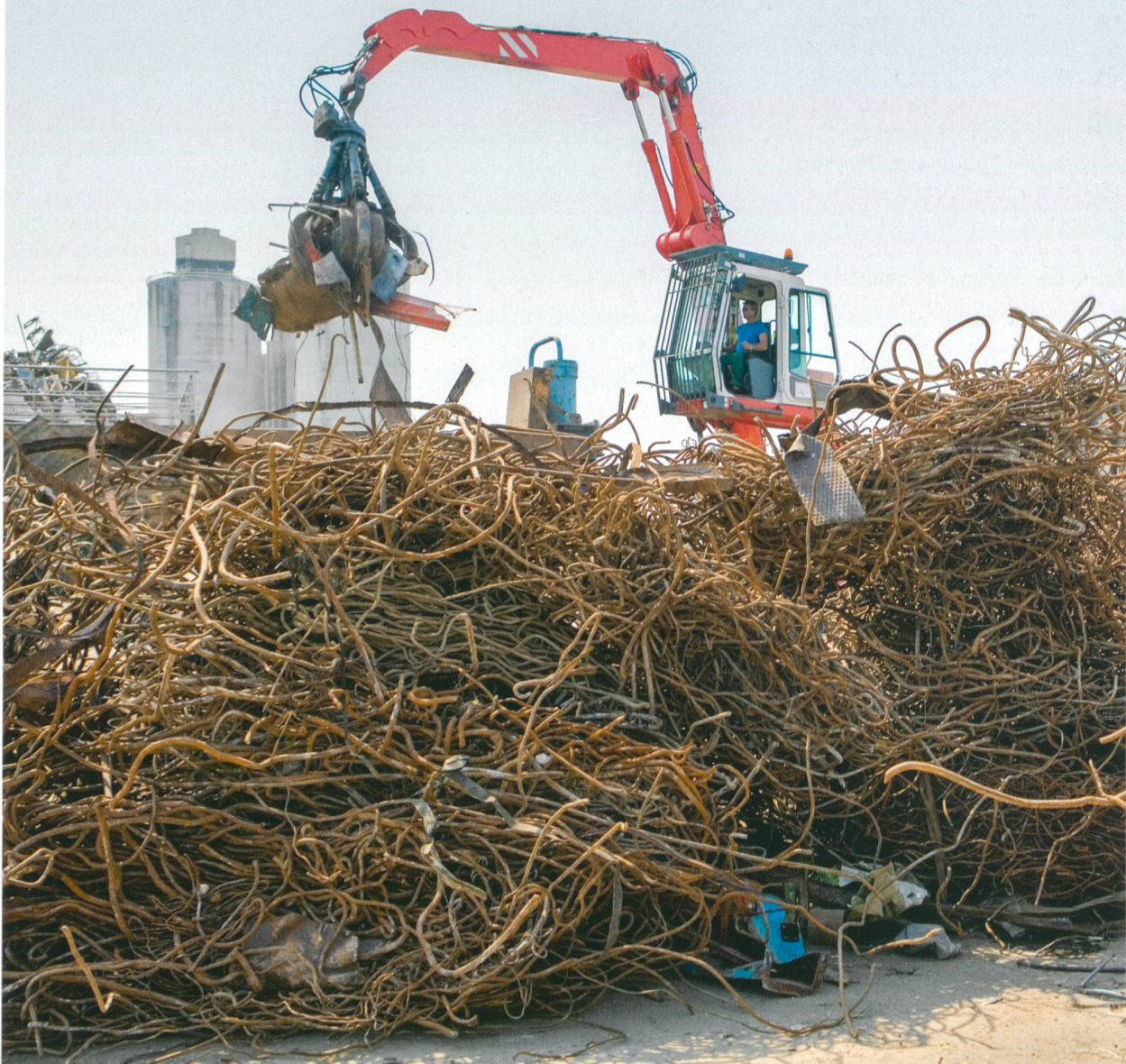
Armierungsstahl aus dem Gebäudeabbruch: vom selektiven Rückbau zum weiterverwertbaren Sekundärrohstoff.
