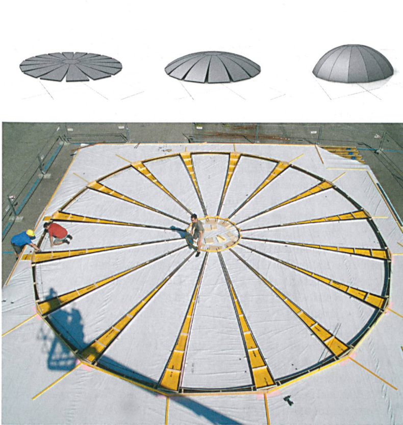
Eine Kreisplatte ist durch keilförmige Aussparungen in einzelne Segmente geteilt, die sich beim Krümmen zu einer Schale zusammenschließen.
