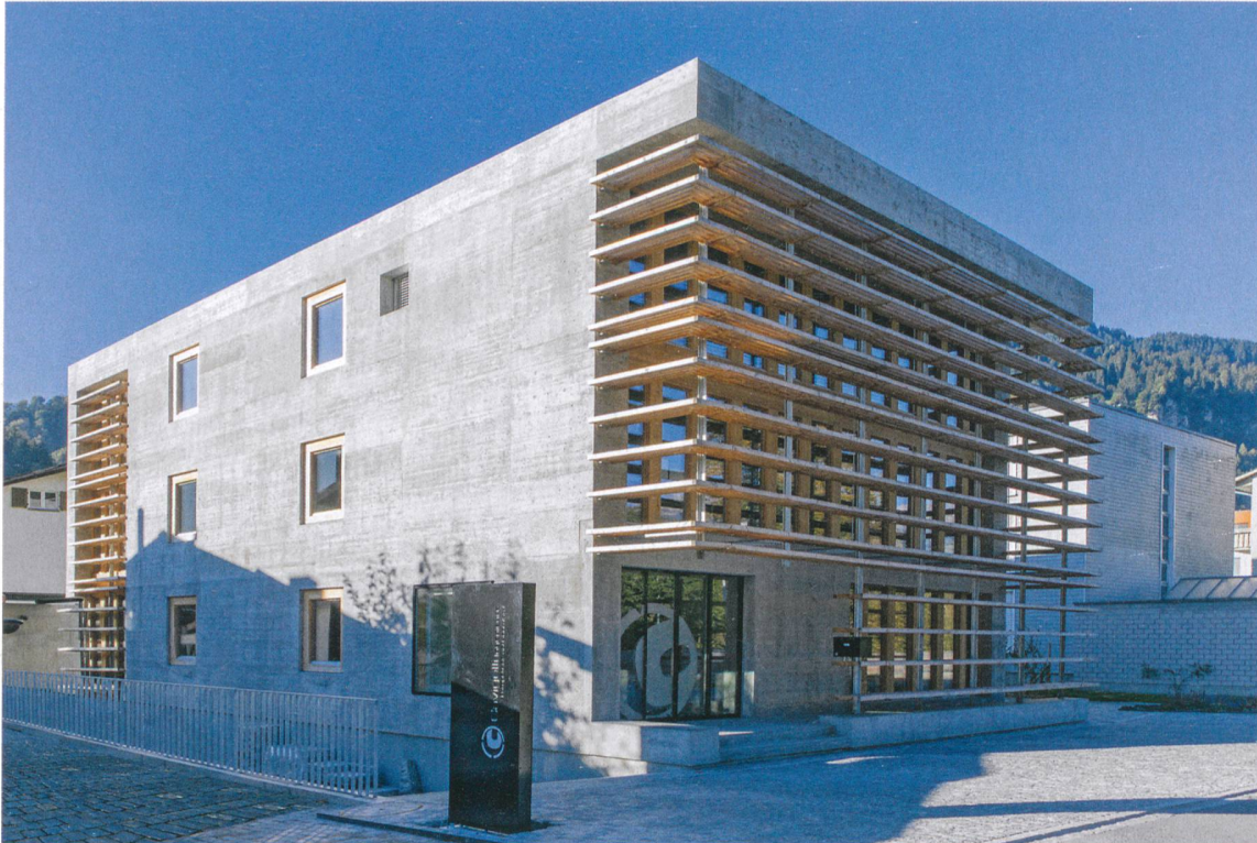
«Norman Foster Solar Award»-Preisträger 2015 ist der Firmensitz der Cavigelli Ingenieure in Ilanz GR. Die Solaranlage auf dem Dach (Abb. unten) ist nur von oben zu sehen. Lamellen verschatten die Fenster und tragen zur guten Energiebilanz bei.
