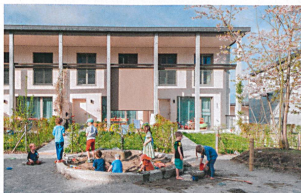
Dichter und vielseitiger: die Ersatzneubauten von 2014.
