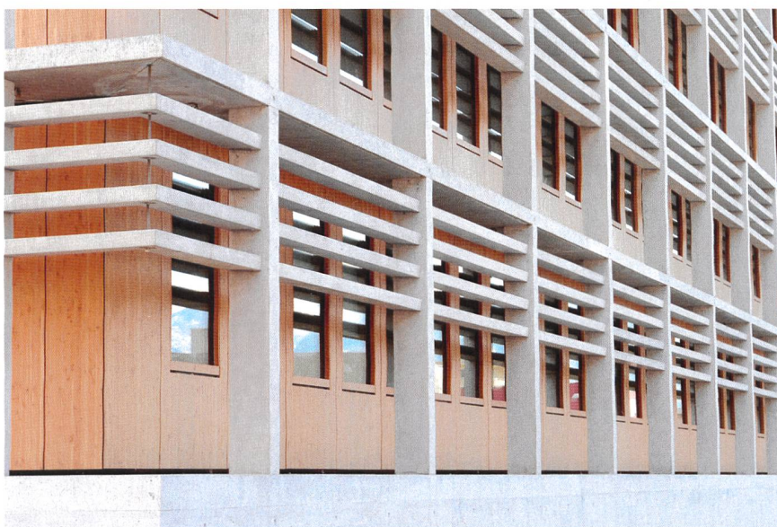
Foto: Holzbau Kayser
