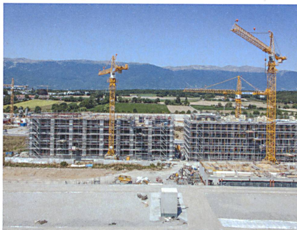
Das Ökoquartier «Les Vergers» in Meyrin GE mit 34 neuen Gebäuden für total 3000 Bewohner ist derzeit im Bau.
