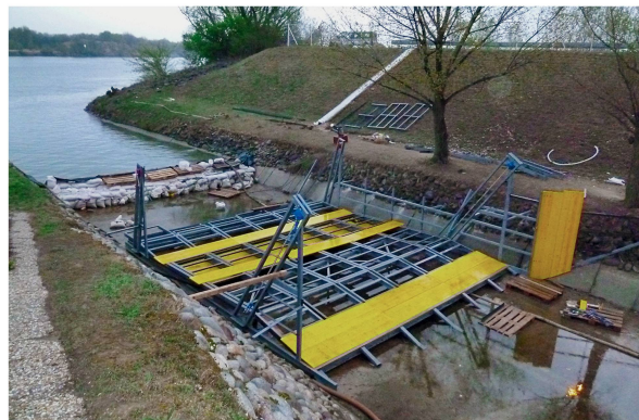
Schema der Anlage in Cunovo (oben) und Foto der beplankten Stahlkonstruktion (darunter). Künftig soll die Anlage auf Knopfdruck aktivierbar sein. Die Planung läuft gerade.
