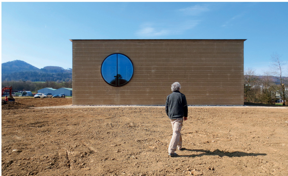
Für das neue Kräuterzentrum von Ricola hat Martin Rauch die Vorfertigung perfektioniert . Das Material der Fassaden stammt aus der unmittelbaren Umgebung: Ton in Ton ragt das Haus kurz vor seiner Vollendung aus dem noch unbestellten Acker.
