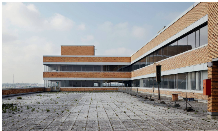
Die Dachterrasse des stillgelegten Quelle-Grossversandzentrums in Nürnberg von Ernst Neufert.
