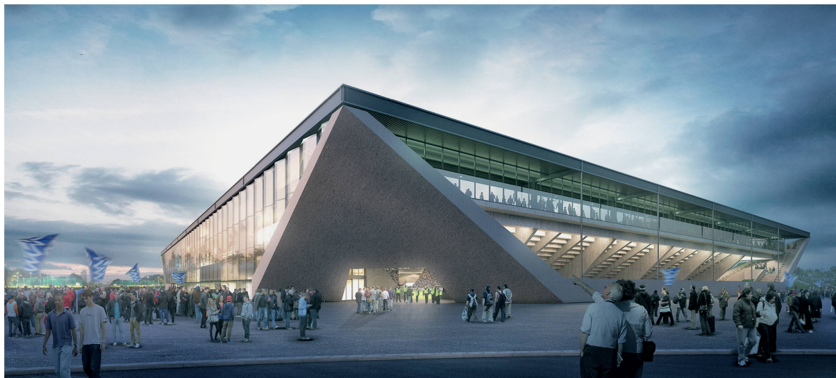
1. Preis «Stade de la Tuilière»: Dreieckige, geneigte Ortbetonwände überdachen und signalisieren die Haupteingänge.
