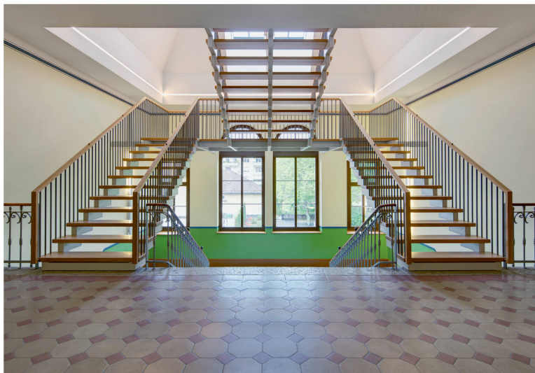
Grosses Länggassschulhaus in Bern: Übergang vom bestehenden Treppenhaus in die neu konstruierte Treppenanlage zum ausgebauten Dachgeschoss.
