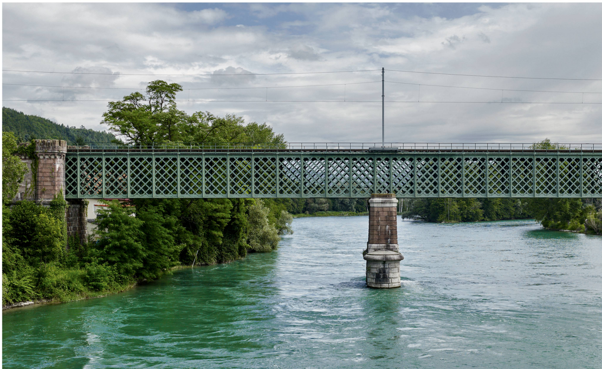
Seit 1859 überspannt die «Gitterlibrücke» mit filigranem Diagonalfachwerk bei Koblenz AG den Rhein. Jetzt will die Deutsche Bahn die älteste Bahnbrücke zwischen Deutschland und der Schweiz abbrennen.
