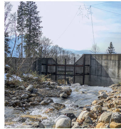
Geschiebesammler im Einzugsgebiet des Altdorfbachs in Vitznau. Seine Kapazität vermag lediglich das Material eines Murgangereignisses mit Wiederkehrdauer von 30 Jahren aufzunehmen.
