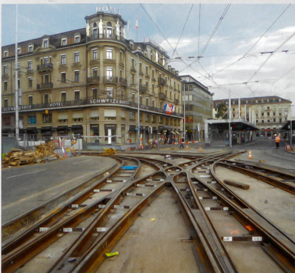
Gleisersatz Bahnhofplatz, Zürich
