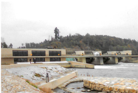
Das Maschinenhaus ist in das Wehr integriert. Über die Wehrbrücke führt eine beliebte Veloroute entlang des Bielersees.
