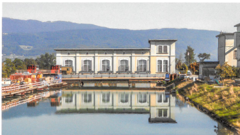
Im alten Maschinenhaus bleibt eine Turbine in Betrieb. Künftig dient das Gründungskraftwerk der BKW Schulklassen und Besuchern als Anschauungsobjekt.
