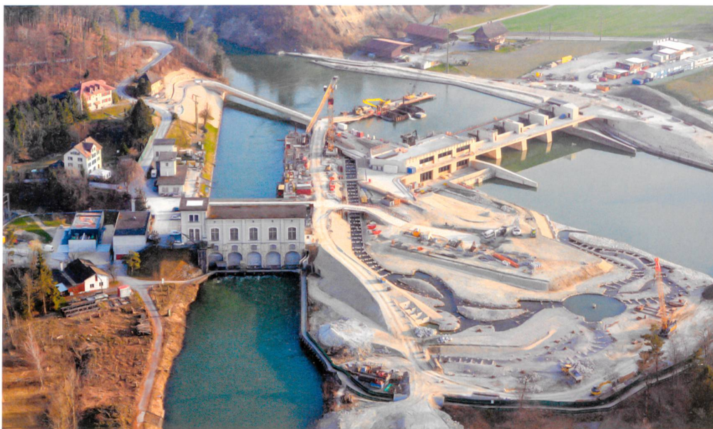
Altes und neues Kraftwerk Hagneck mit dem Umwegungsgewässer in einer Aufnahme vom März 2015.
