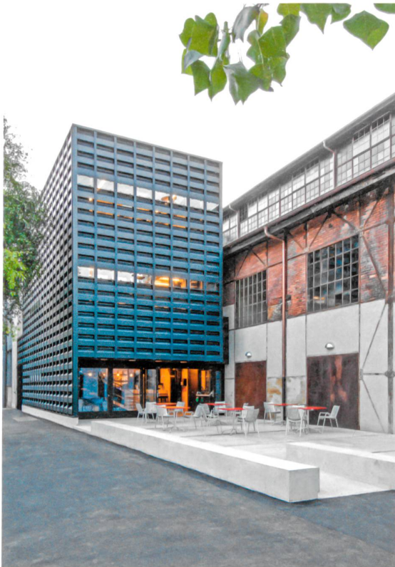
Der neue Vorplatz bildet den Auftakt zum Kulturlokal «Merkker». Die Fassade des Anbaus besteht aus Gusstahlelementen, die auf die frühere Nutzung als Schmiede verweisen.
