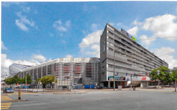
Südansicht des extravaganten St. Jakob-Parks mit Stadionerweiterung (links), Altersheim und Shoppingcenter (rechts).
