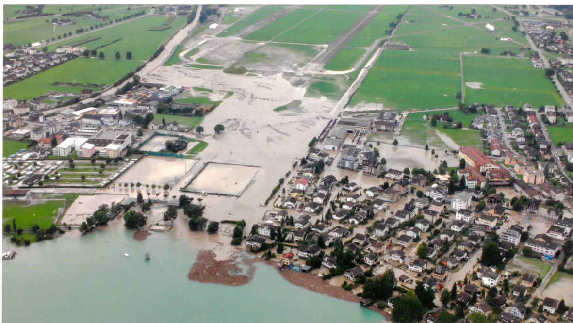
Jahrhunderthochwasser 2005 an der Engelberger Aa mit teilweise kontrolliertem Abfluss: Die Überflutung des Kulturlands (linke Bildhälfte) war in Kauf genommen worden; die Schutzmassnahmen gegenüber dem Siedlungsteil von Ennetbürgen (rechte Bildseite) waren damals noch nicht umgesetzt.
