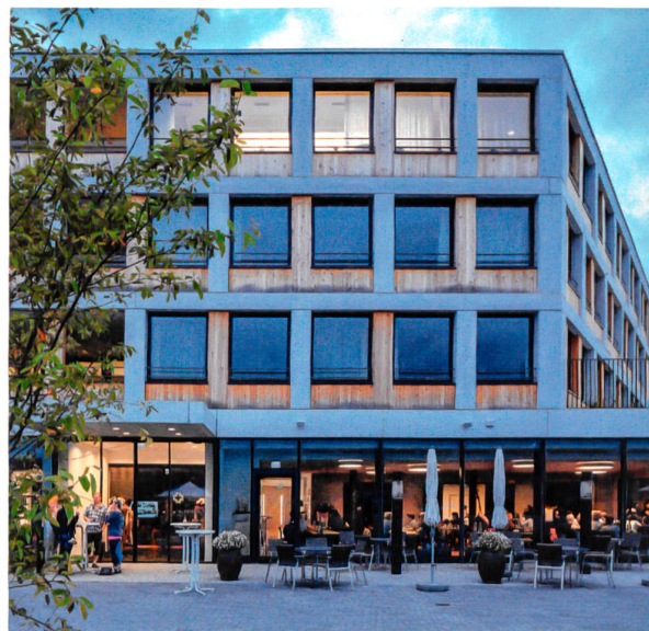
Aussenansicht des Alterszentrums Appenzell. Im obersten Geschoss gut erkennbar ist die dynamische Lichtdecke. Die Lichtdecken in den Aufenthaltsräumen werden über Bewegungsmelder aktiviert.
