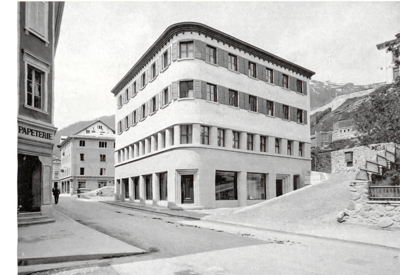
Wohn- und Geschäftshaus mit Restaurant in Samedan, erbaut 1930, ab den 1970er-Jahren Hotel Donatz. Architektur: Enrico Bisaz und Jachen Ulrich Könz.
