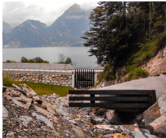
Murgangbremse und Geschiebesammler am Dornbach bei Sisikon UR.
