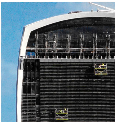
Die Südfassade mit nachträglich montierten Sonnenschutzlamellen .
