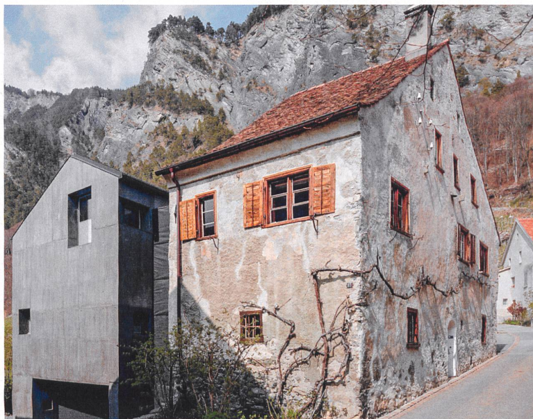
Die Weiterentwicklung alpiner Regionen ist auch eine architektonische Aufgabe: Der Architekt Kurt Hauenstein erhielt für seine sensible Erweiterung eines historischen Bauernhauses in Fläsch GR 2010 den Wakkerpreis des Schweizer Heimatschutzes.
