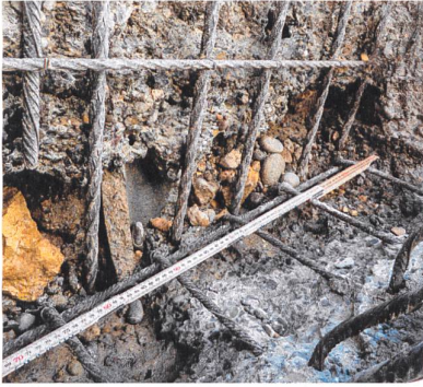
Hauptbewehrung eines Stützbauwerks mit niedrigem Korrosionsgrad und Querschnittsverlust.
