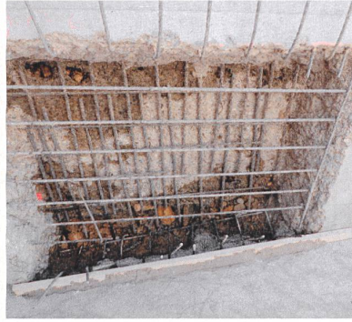
Hauptbewehrung eines Stützbauwerks mit niedrigem Korrosionsgrad und Querschnittsverlust.
