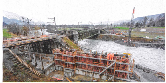
Baugrube des definitiven Widerlagers unter den Behelfsbrücken im Eisenbahndamm mit der Schalung des linksufrigen Vorschublagers.
