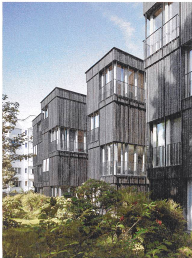
Aussenansicht des Hofhauses.
