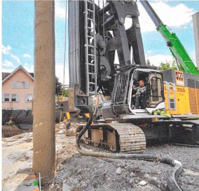
In Zug erstellte die JMS Risi eine Baugrube innerhalb einer wasserdichten Baugrubenumschliessung, da die Grube mit bis zu zwei Untergeschossen im Grundwasser lag. Schlitz- und Spundwände zur Sicherung liessen sich aufgrund der Platzverhältnisse und zu befürchtender Lärm- und Erschütterungsemissionen nicht realisieren. Man setzte daher auf eine überschnittene Bohrpfehlwand mit Pfahldurchmesser 770 mm, die mit dem neuen Bohrgerät Liebherr LRB355 im Doppelkopfbohrverfahren erstellt wurde. •
