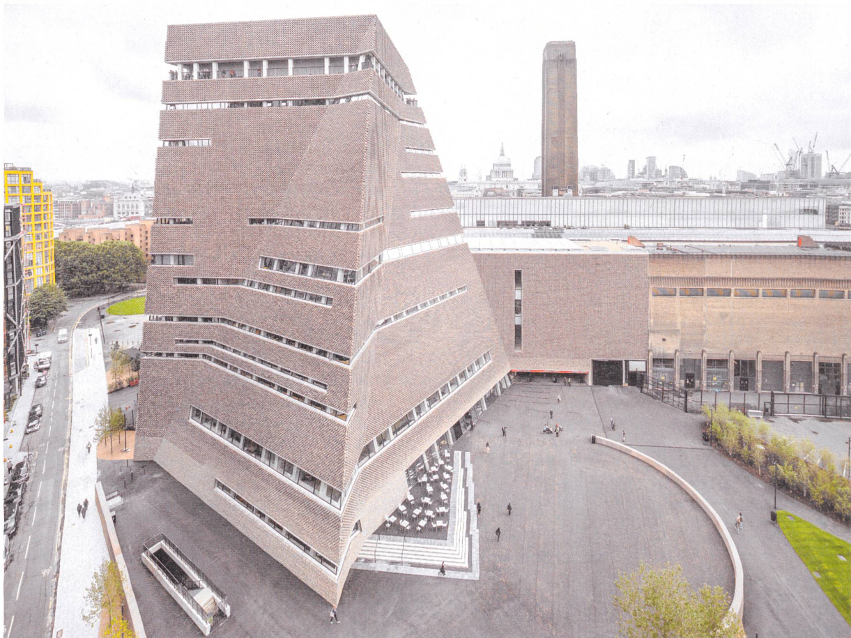
Das perforierte Mauerwerk – von der tragenden Funktion befreit – hüllt die nach innen und aussen gefalteten Flächen der verdrehten und scharfkantigen Pyramide ein wie ein Schleier aus Steinen.
