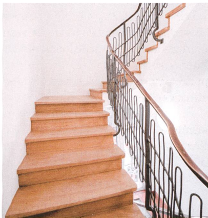
Die nicht Suva-konformen bestehenden Geländer im Nordflügel sicherten die Architekten mit passenden gebogenen Staketenschlaufen.
