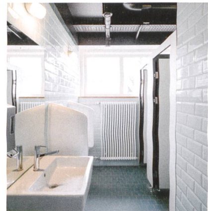
Durch den Verzicht auf eine abgehängte Decke konnten die grossen Fenster in den WCs erhalten werden. Die facettierte Keramik erinnert an die 1930er-Jahre.
