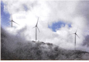
Die höchstgelegene Windenergieanlage Europas steht zwischen Gries- und Nufenenpass, auf 2400 m.ü.M., in der Walliser Gemeinde Obergoms. Diesen Sommer ist der Park auf vier etwa 80 m hohe Windräder mit einer Leistungskapazität von 10 GWh ausgebaut worden. Mit dem erzeugten Strom lassen sich gegen 3000 Haushalte ausreichend versorgen. Coverfoto von Olivier Maire .
