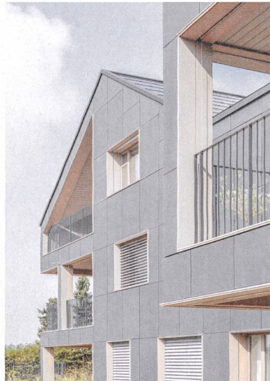
Ein zweiter Preis ging an ein energieautarkes Mehrfamilienhaus an der Unterdorfstrasse in Brütten ZH.
